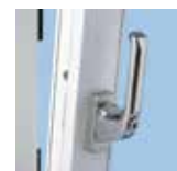
Fenstergriff: Abschließbar und Anbohrschutz vorgeschrieben
